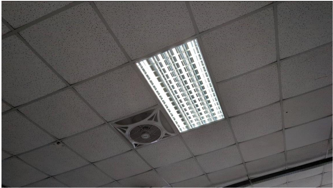
室內使用 LED 燈管
